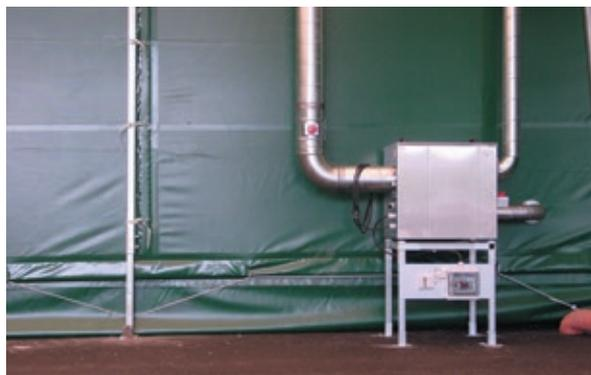
Desumidificador DST Recusorb DR-40 instalado em uma tenda plástica
